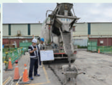
混凝土筏基層回填澆置
