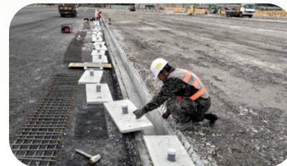
預鑄構件現場安裝
