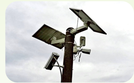
太陽能供電之監視設備
