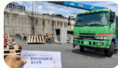
護欄吊運集中放置
