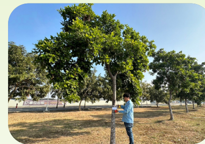
工區植栽移植
